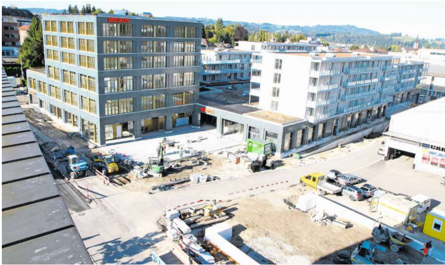
Die Bauarbeiten am «Birkenhof» befinden sich im Finish. Rechts im Bild entsteht ein neuer Platz in Nähe der Uze.
