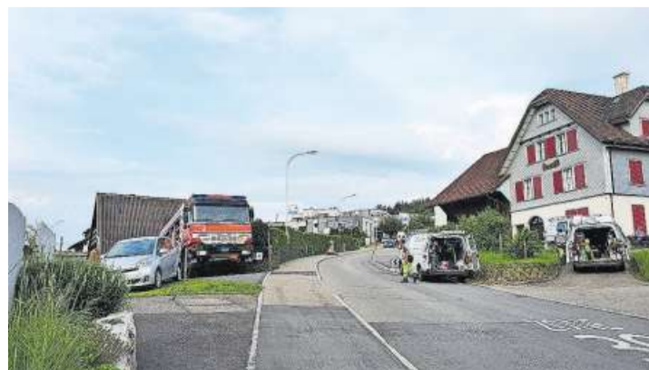
In der Trafostation an der Ulrich-Rösch-Strasse musste Wasser abgepumpt werden.
