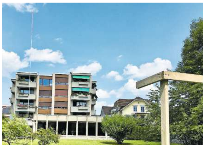
Rechts im Vordergrund ist ein Bauvisier der Grundeigentümer sichtbar, links vor dem Hochbau eines der Anstösser. Bild: Andrea Häusler
