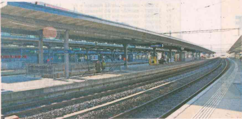
Wil: Der Bahnhof ist nicht autonom und spontan benutzbar. Laut Prognose wird er im Jahr 2021 umgebaut. Die Haltestelle der Frauenfeld-Wil-Bahn ist bereits barrierefrei. Infrastrukturbetreiberin ist die SBB und die FW-Bahn.
