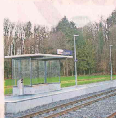
Rosental: Der Bahnhof ist nicht konform. Er wird bis 2023 barrierefrei sein. Infrastrukturbetreiberin ist die FW-Bahn.
