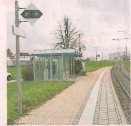
Tägerschen: Der Bahnhof ist bereits autonom und spontan benutzbar. Infrastrukturbetreiberin ist THURBO.
