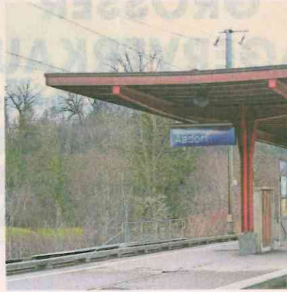
Aadorf: Der Bahnhof soll voraussichtlich 2021 barrierefrei umgebaut werden. Infrastrukturbetreiberin ist die SBB.
