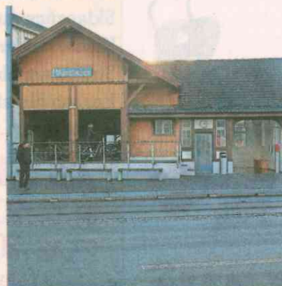
Münchwilen: Der Bahnhof ist nicht konform. Er wird bis 2023 barrierefrei sein. Infrastrukturbetreiberin ist die FW-Bahn.
