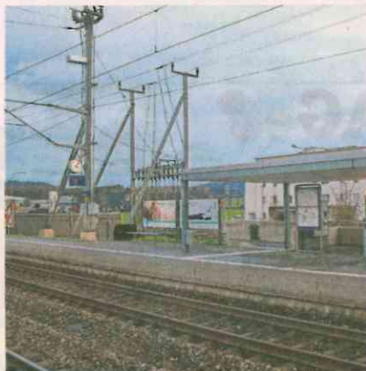
Eschlikon: Der Bahnhof ist bereits autonom und spontan benutzbar. Infrastrukturbetreiberin ist die SBB.
