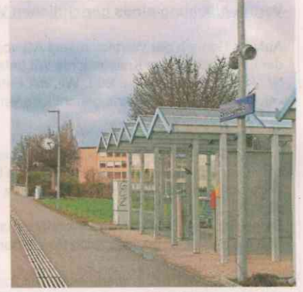
Bronschhofen: Der Bahnhof ist bereits autonom und spontan benutzbar. Infrastrukturbetreiberin ist THURBO.
