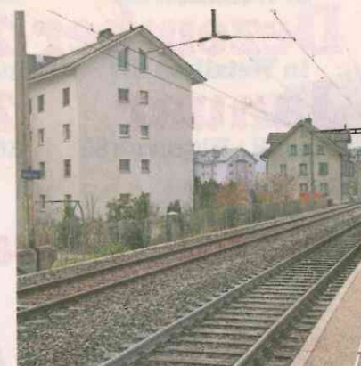
Bazenhaid: Der Bahnhof ist bereits autonom und spontan benutzbar. Infrastrukturbetreiberin ist die SBB.
