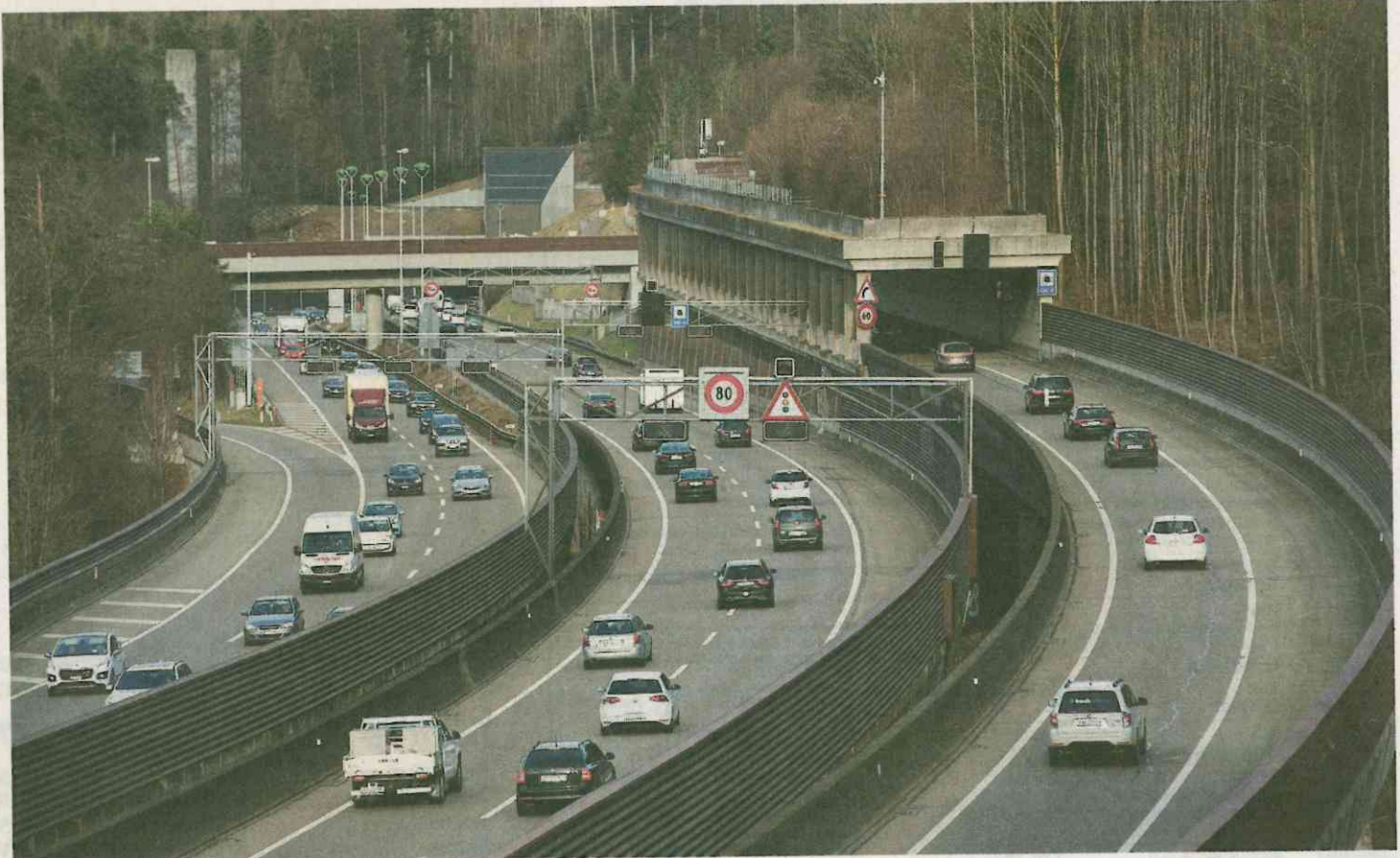
Das grösste Strassenbauprojekt im Kanton ist die Engpassbeseitigung des überlasteten Stadttunnels.
