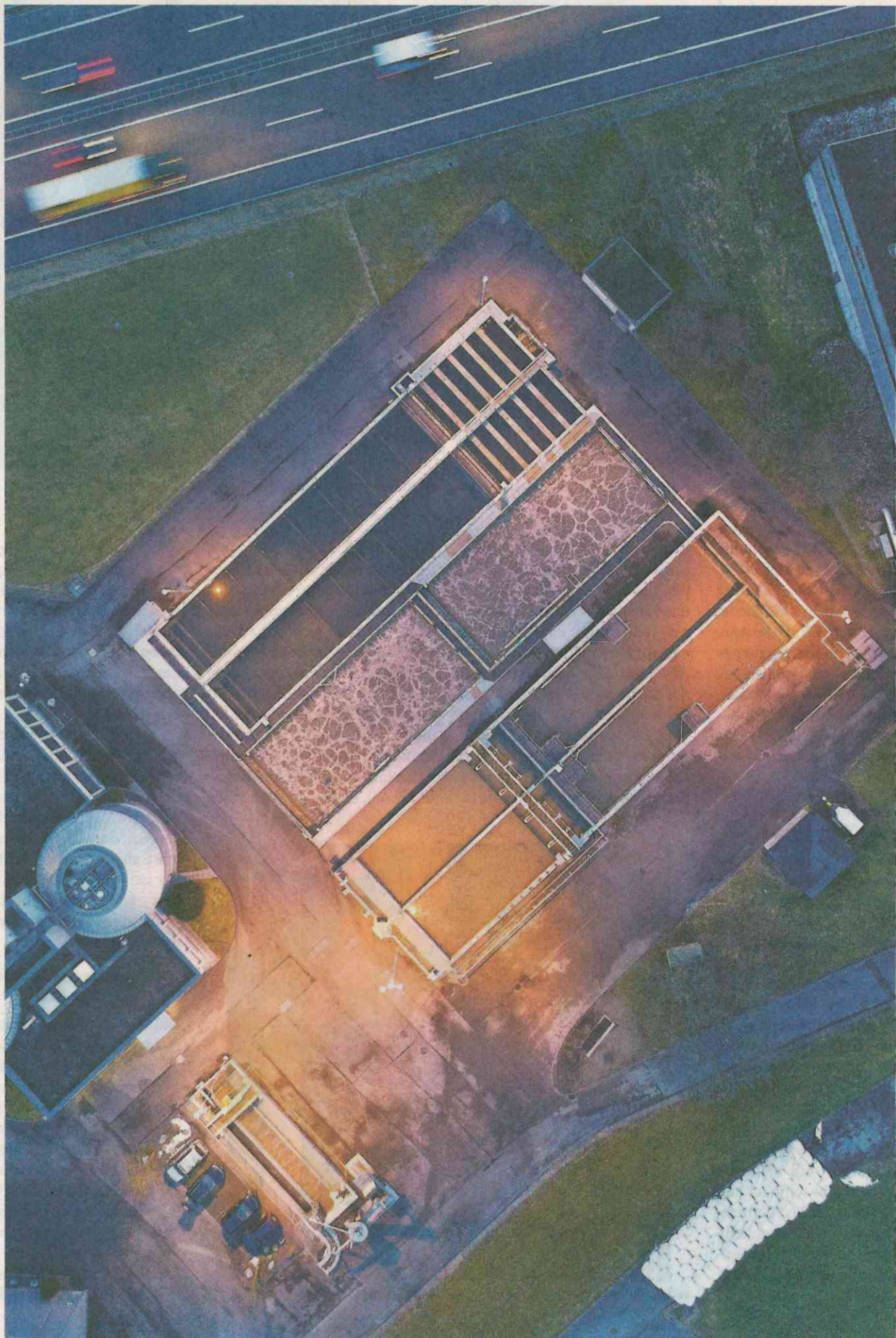
Blick von oben auf die Abwasserreinigungsanlage nahe der Autobahn A1 in Niederuzwil. «Eine ARA wird in zunehmendem Mass auch zu einer Energiezentrale», sagt Lucas Keel. Aus Reststoffen lässt sich Energie gewinnen. Bild: Peter Dotzauer/Bildform Henau
