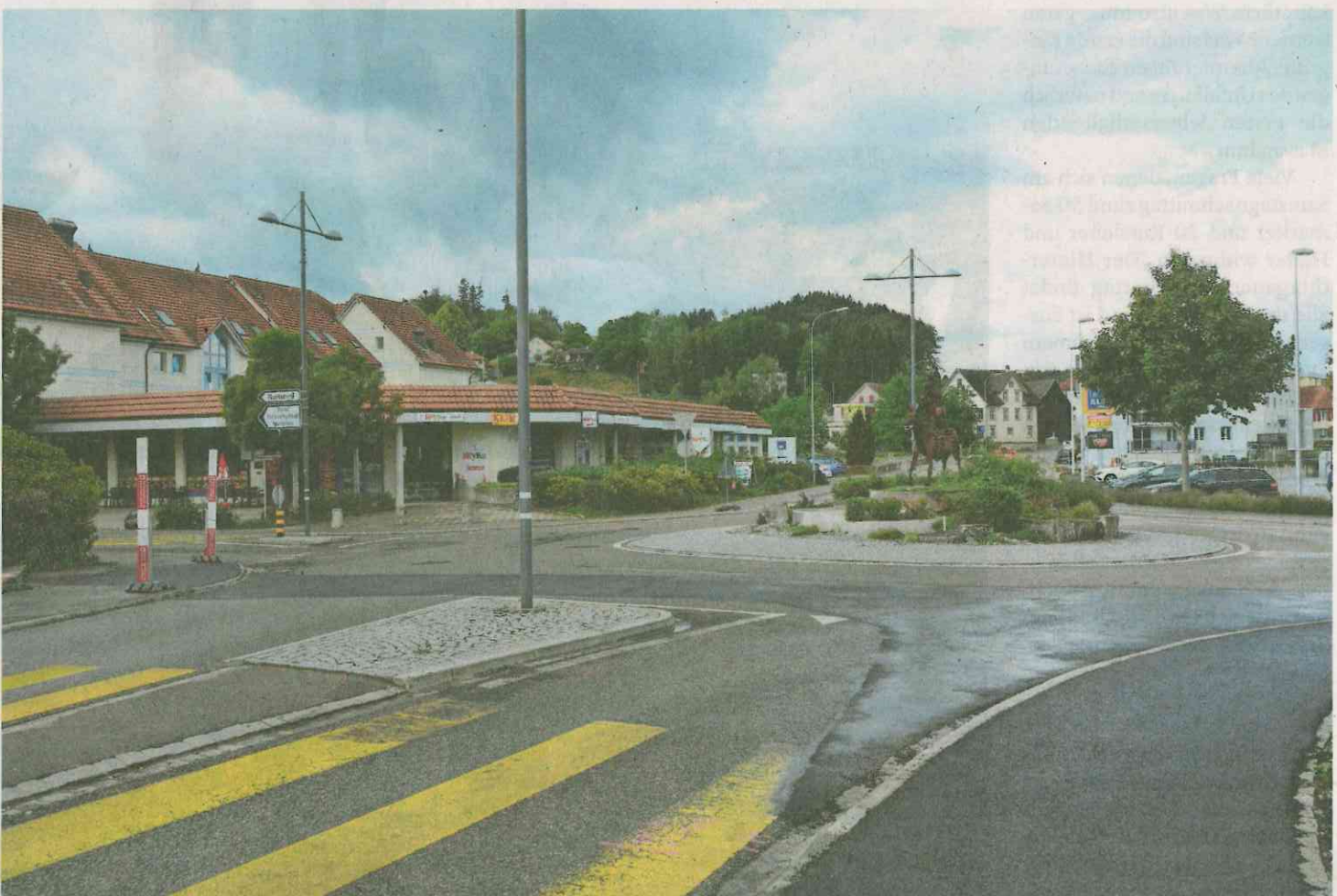
Der Kreisel ist nach einer mehrwöchigen Bauphase wieder ohne Beeinträchtigung des Verkehrs befahrbar.
