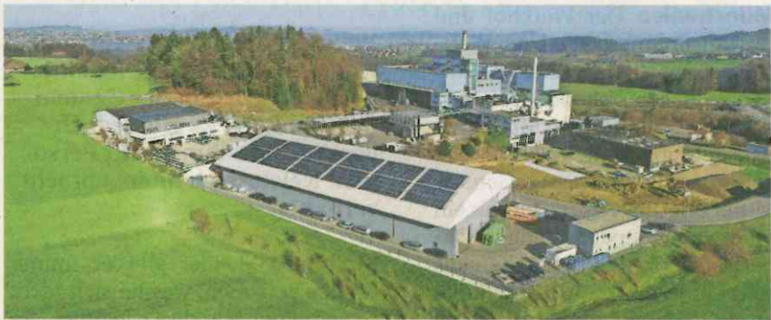
Energiepark Bazenheid mit erneuerbarer Energie aus unterschiedlichen Quellen: Energie aus Abfällen und Biomasse sowie Solarenergie aus den Photovoltaikanlagen. z.Vg.
