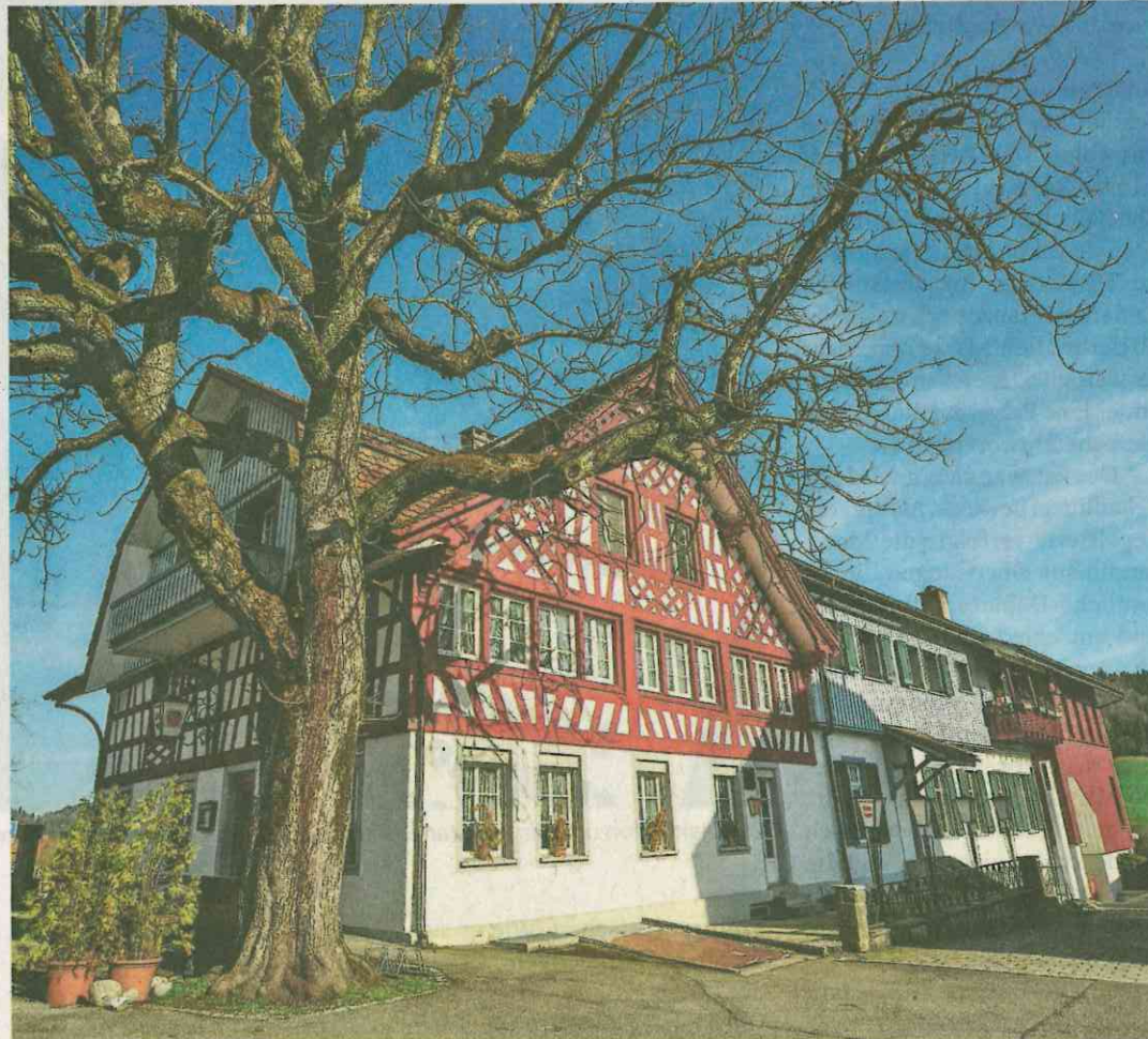
Das «Landhaus» ist im Besitz der Gemeinde Bichelsee-Balterswil und soll nun saniert und umgebaut werden.
