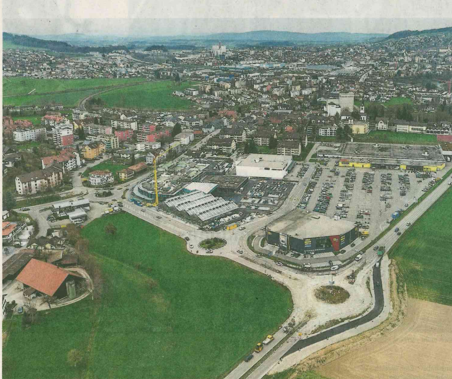
Der temporäre Bypass des Breiti-Kreisels (rechts) wird breiter, damit er in beide Richtungen befahren werden kann.
