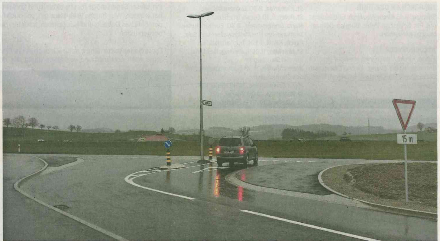
In der anderen Fahrrichtung kann nur noch jeweils ein Fahrzeug einfädeln. Eine grosse Fläche dient dem Schwerverkehr zum Abbiegen.
