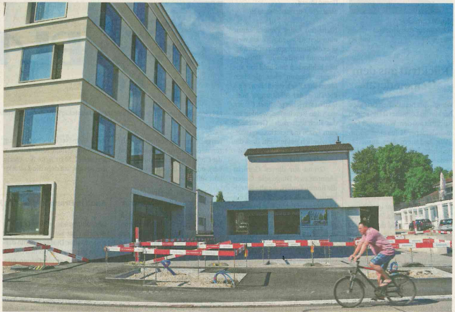
Parkplätze gibt es vor dem neuen Uzwiler Gemeindehaus keine, dafür einen grossen Velounterstand.
