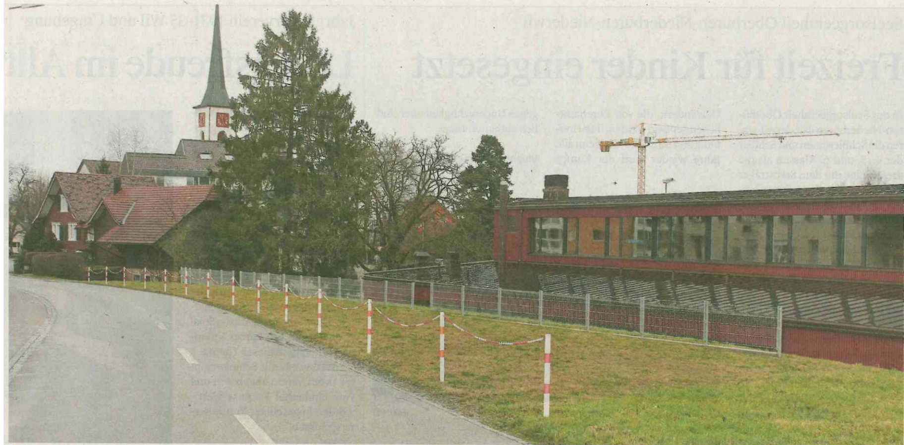
Die Ketten können entfernt werden, wenn das Areal während einer Veranstaltung als Parkplatz benützt werden soll. Allerdings unter Auflagen.
